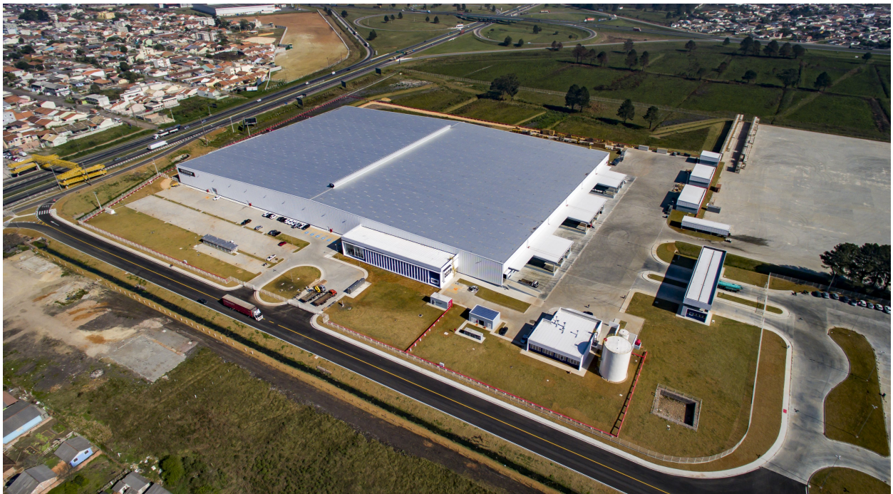
Figura nº 03 – Detalhe do complexo logístico já instalado e dos acessos ao mesmo. A ampliação prevista deverá ocorrer nos fundos da unidade.
