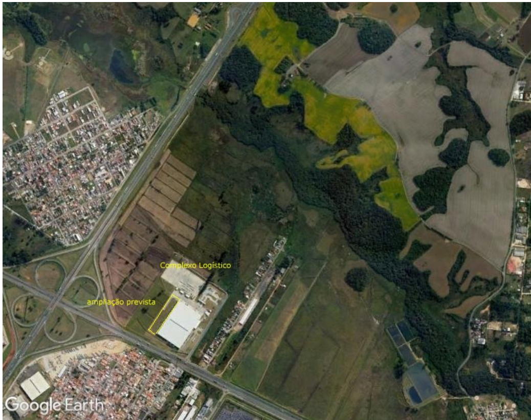
Figura nº 02 – Detalhe do imóvel, com o complexo logístico já instalado e a indicação da ampliação prevista (retângulo amarelo junto à edificação já existente). (Fonte: Google Earth, 2021).
