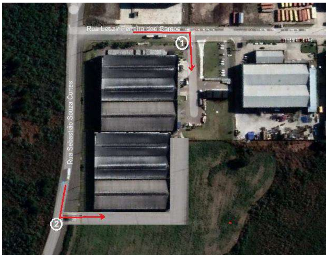
Figura 7. Acesso à empresa
