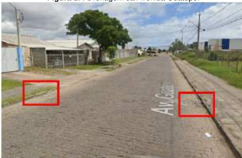
Figura 17: Drenagem da Avenida Guatupê.
