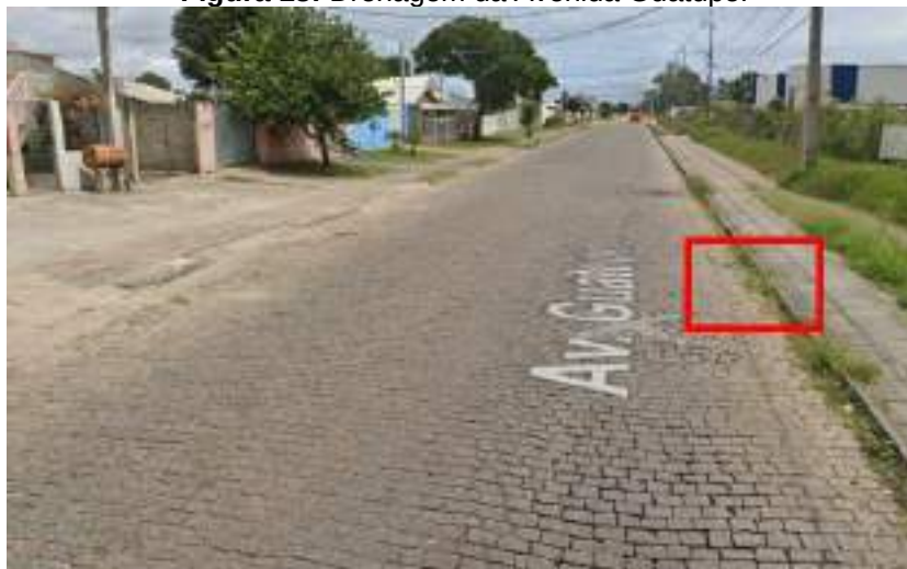
Figura 18: Drenagem da Avenida Guatupê.
