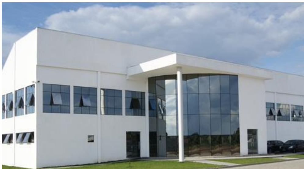
Figura 1: Fachada do empreendimento existente.
