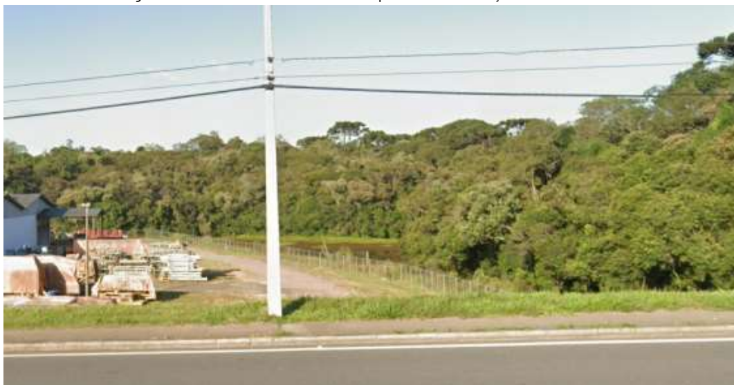
Figura 13. Divisa direita do imóvel: represa de contenção existente
