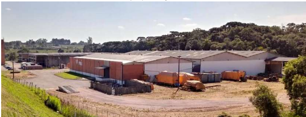
Figura 11. Construção existente aprovada pelo Alvará nº 1/1997 e CVCO nº 343/2001, e respectiva ampliação a regularizar
