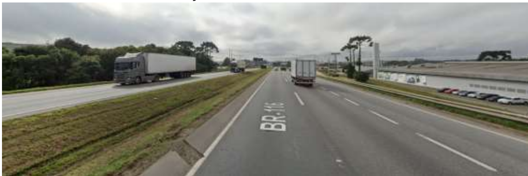
Figura 25. Rodovia Federal BR-116
