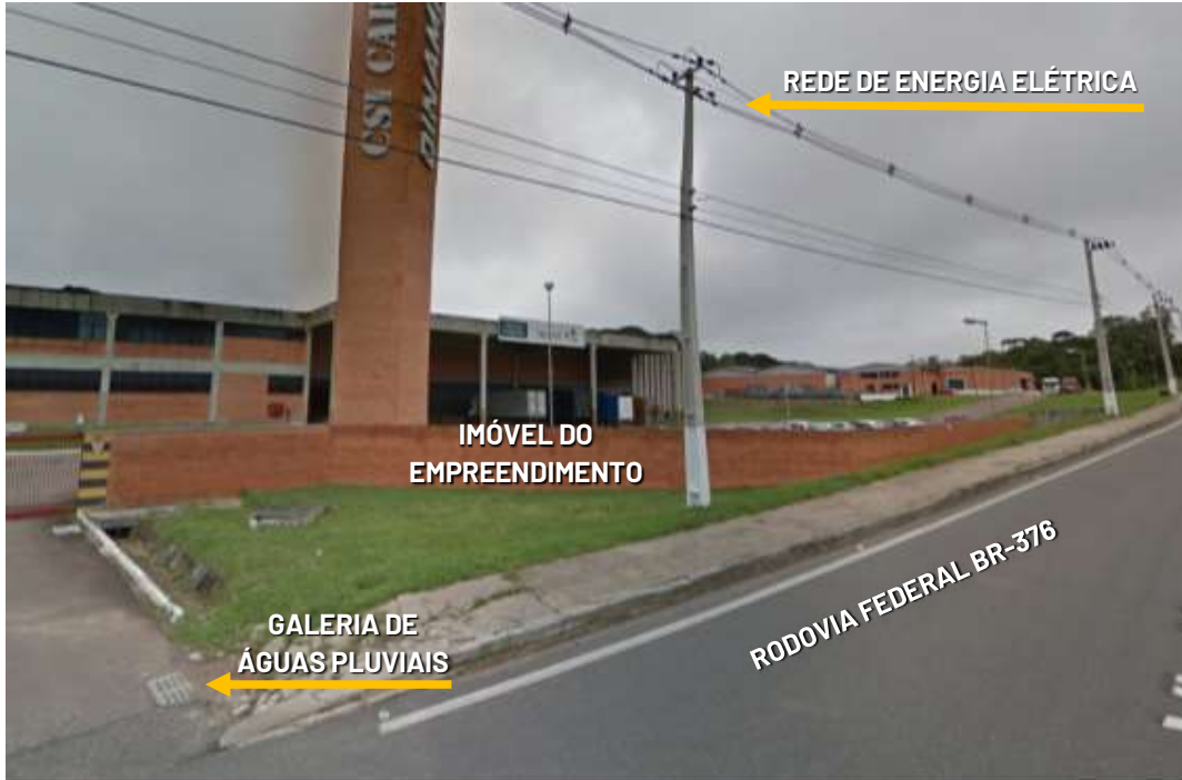
Figura 15. Infraestrutura existente na via de acesso ao empreendimento
