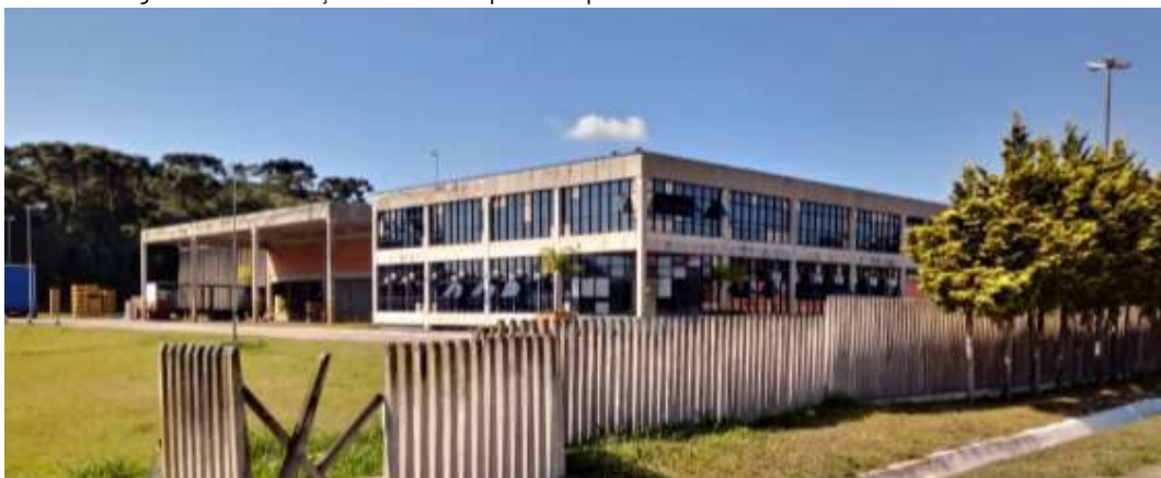
Figura 10. Construção existente aprovada pelo Alvará nº 278/1995 e CVCO nº 343/1996
