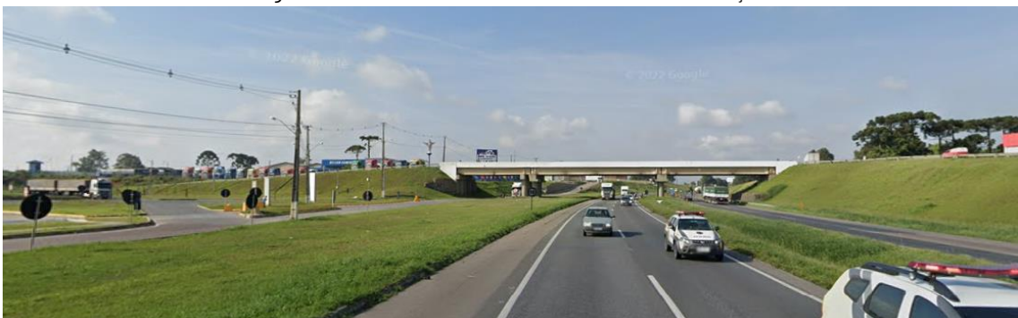
Figura 22. Rodovia Federal BR-116, via de distribuição
