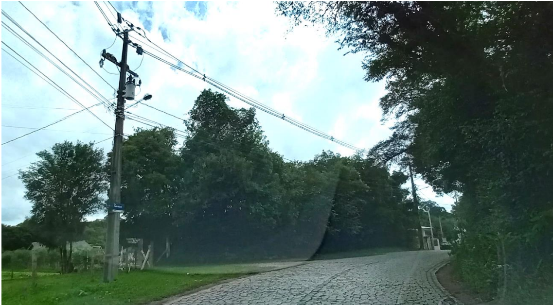
Figura 20. Rua Pedro Valaski, via de distribuição
