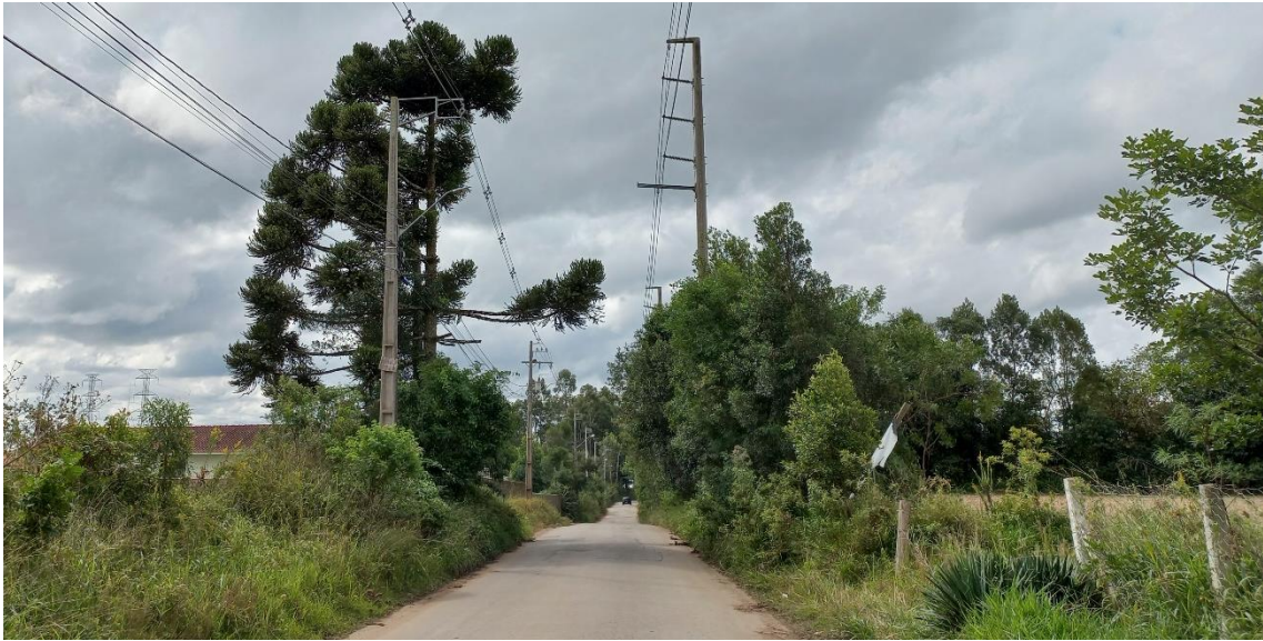
Figura 11. Rua Joaquim Aves Fontes, em trecho defronte ao imóvel
