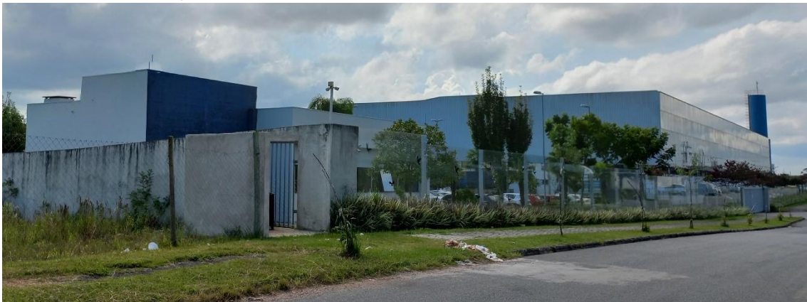
Figura 10. Vista do interior do terreno – construções existentes
