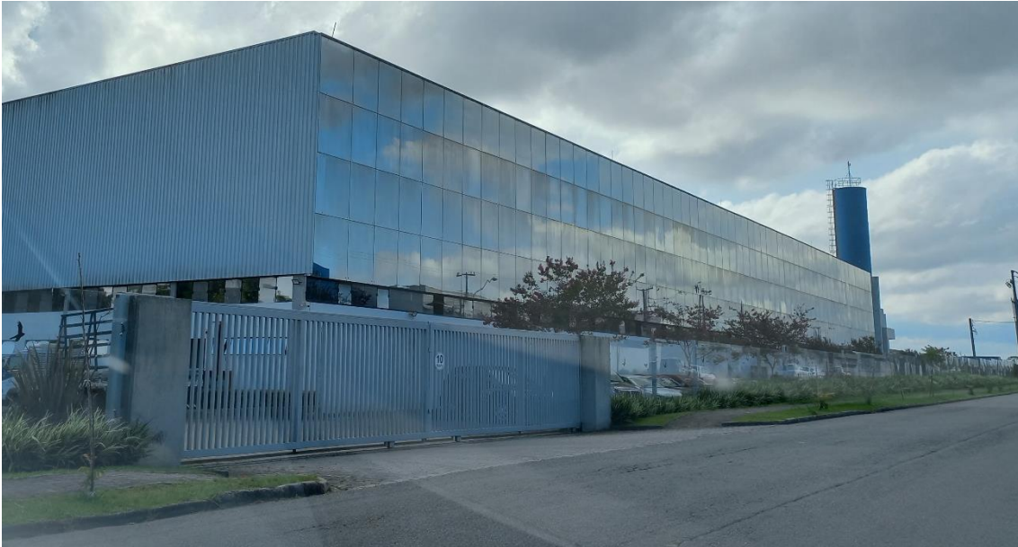
Figura 13. Vista interior do terreno – acesso de veículos
