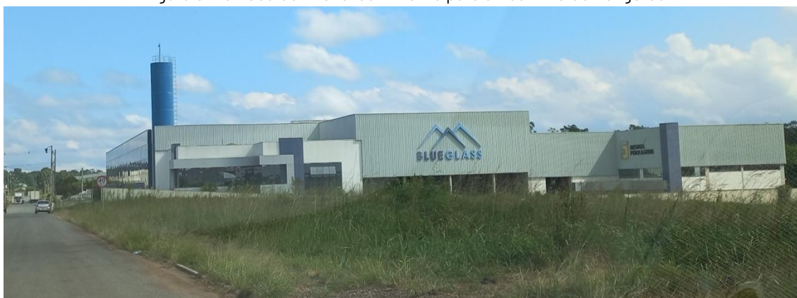
Figura 8. Testada do imóvel com frente para a Rua Arnaldo Vosgerau
