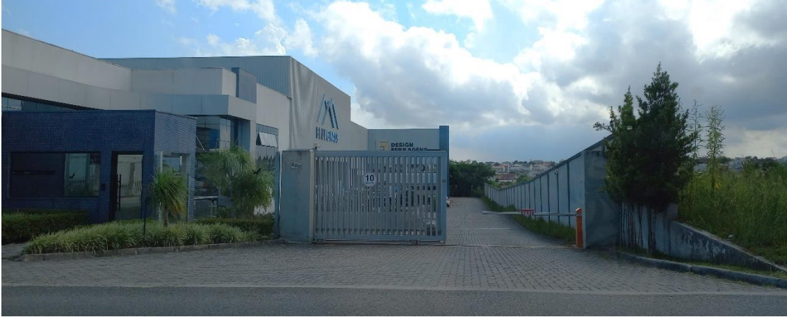
Figura 12. Vista interior do terreno – acesso de veículos
