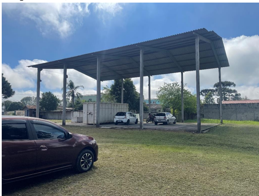
Fotografia 6: Empreendimento: Barracão (aberto)
