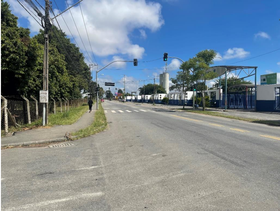
Fotografia 11: Rua Doutor Murici: em frente ao empreendimento – I
