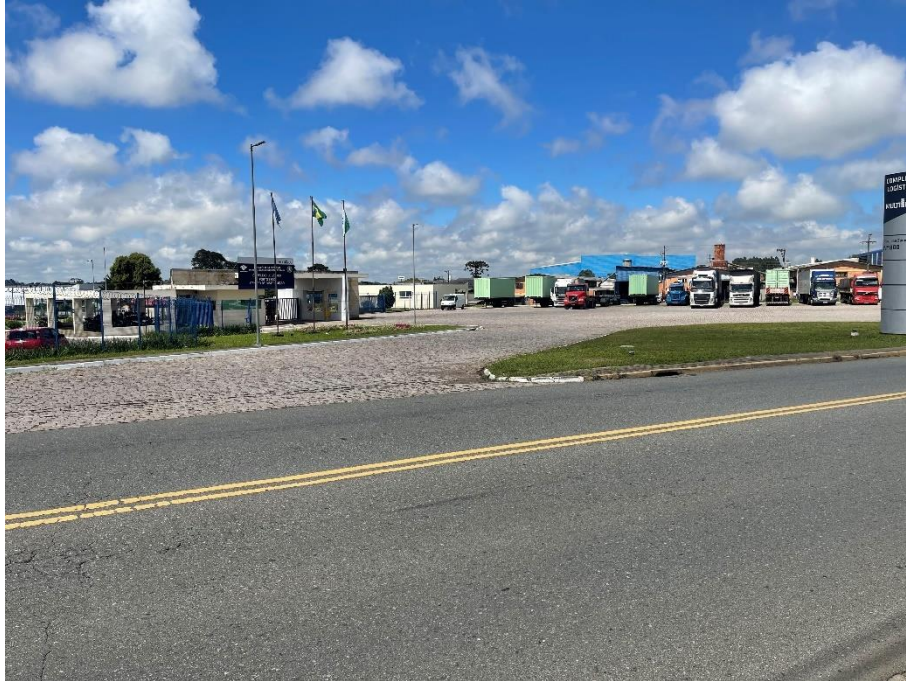
Fotografia 55: Rua João Zarpelon: Equipamento logístico
