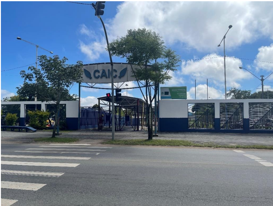
Fotografia 32: Rua Doutor Murici: Equipamento público de assistência social, educação e saúde
