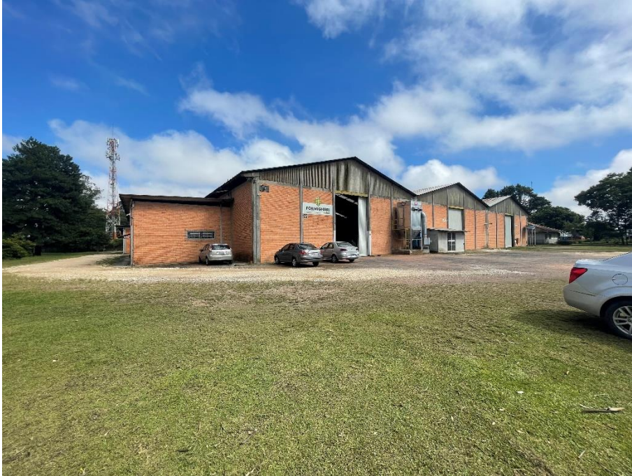
Fotografia 3: Empreendimento: Barracão (fechado) – I
