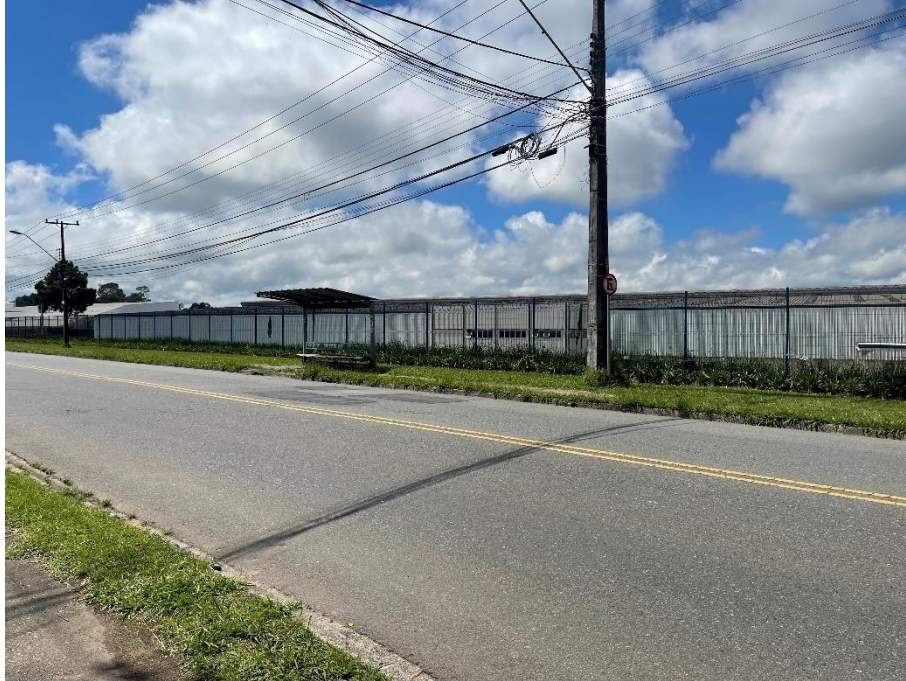
Fotografia 29: Rua João Zarpelon: Ponto de Ônibus – II
