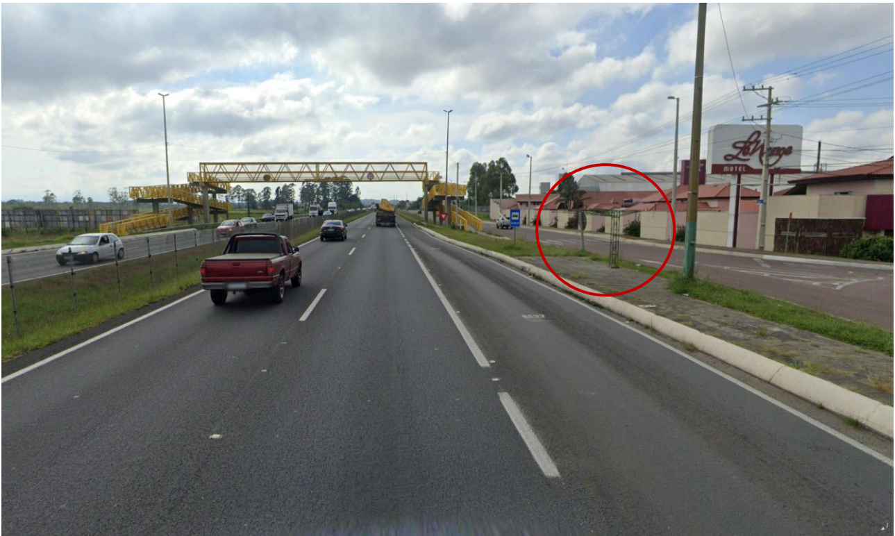
Figura 41: Parada de Ônibus da Rodovia BR-277.
