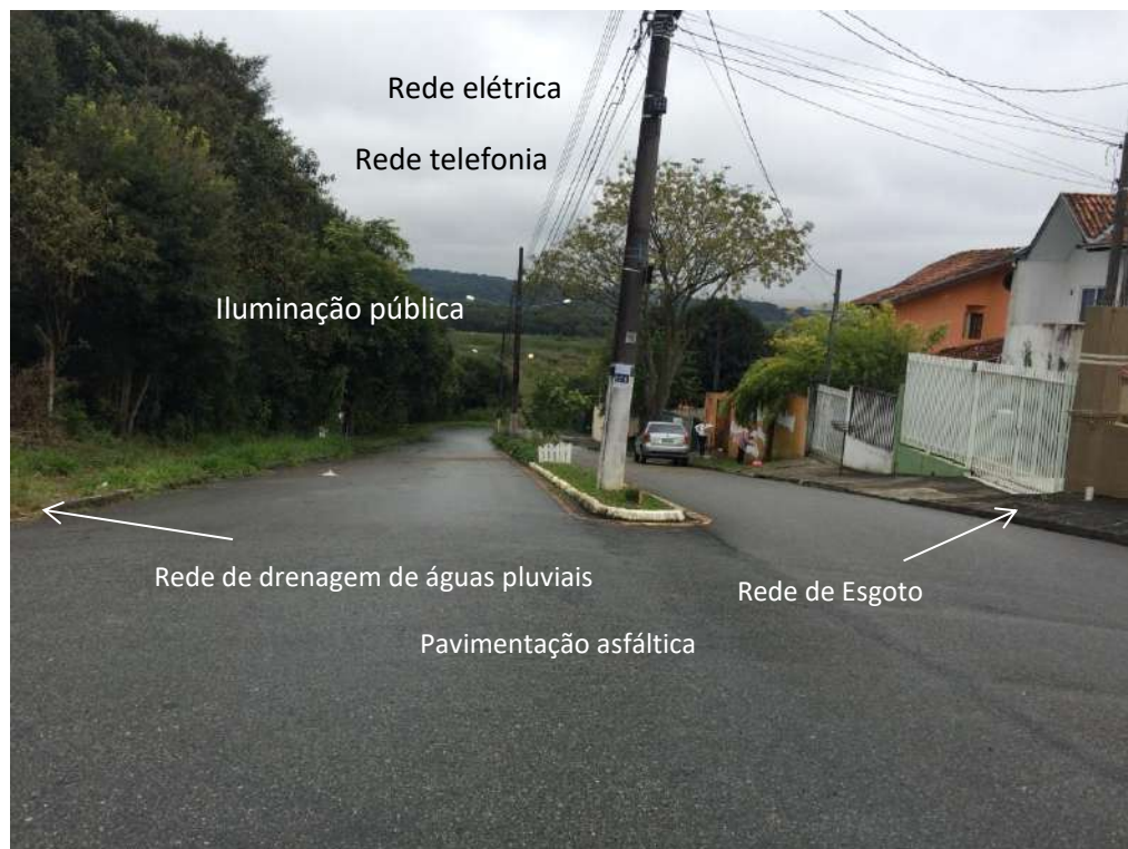
Figura 3.5. Infraestrutura existente na Rua Zacarias Alves Pereira
