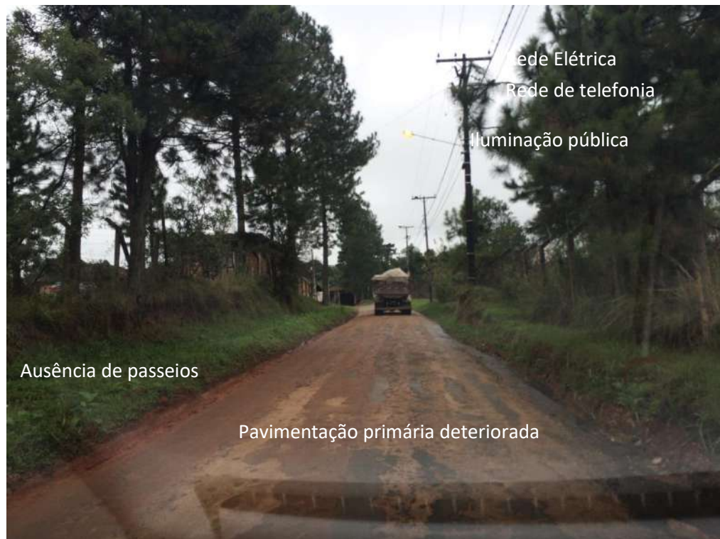
Figura 3.6. Infraestrutura existente na Rua Antônio Zaramella
