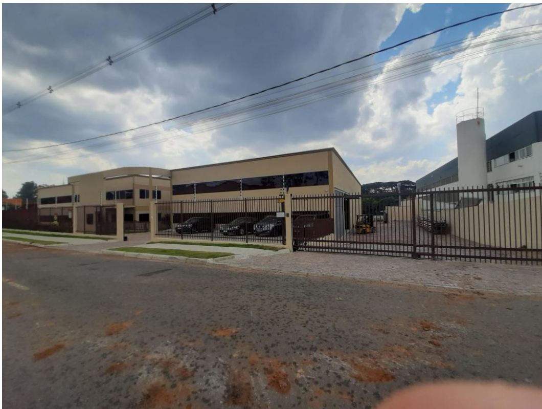
Acesso ao Imóvel, Carga e Descarga. Portão de acesso ao imóvel, infraestrutura existente, à água, Energia Elétrica, Asfalto.
