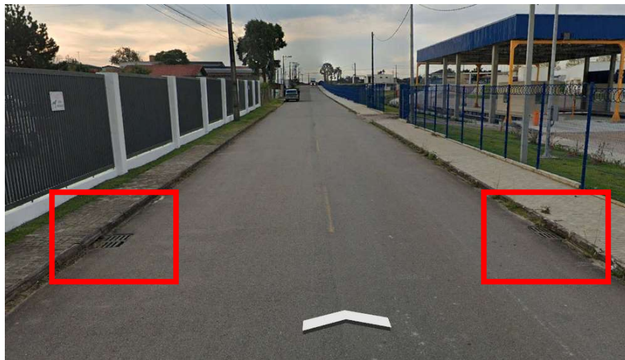
Figura 16: Drenagem da Rua Ângelo Costa
