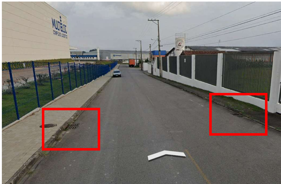
Figura 15: Drenagem da Rua Ângelo Costa
