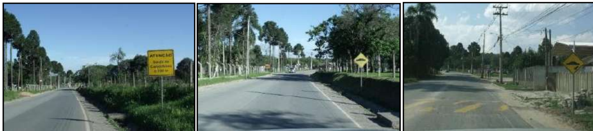
FOTO 16 – Sinalização indicativa de tráfego pesado e redutores de velocidade no acesso à área do empreendimento pela Rua Benjamin Claudino Barbosa, conforme normatização.
