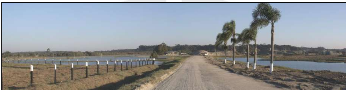
FOTO 26 – A área de mineração possui acessos internos em condições satisfatórias de uso e conservação.
