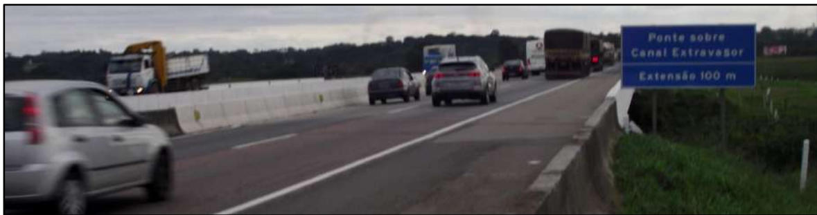
FOTO 04 – Contorno Sul, importante corredor de cargas e passageiros da RMC, no trecho em que transpõe o Canal Extravador do Rio Iguaçu.
