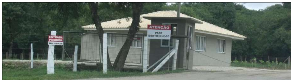
FOTO 17 - Guarita para controle de acesso na entrada da área de mineração.
