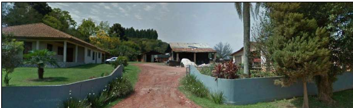
FOTO 05 – Pequenas olarias estão instaladas na AID, em geral de caráter familiar, que fabricam exclusivamente tijolos.
