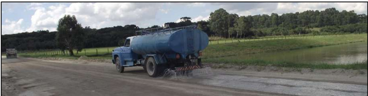
FOTO 30 – Realização de aspersão nas vias internas da mina para controle da emissão de poeira pelo tráfego de máquinas e caminhões.
