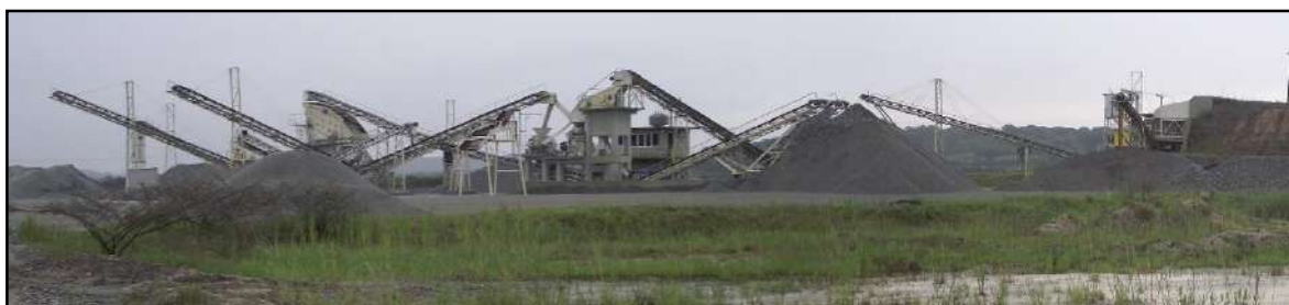
FOTO 20 - Planta de Britagem.
