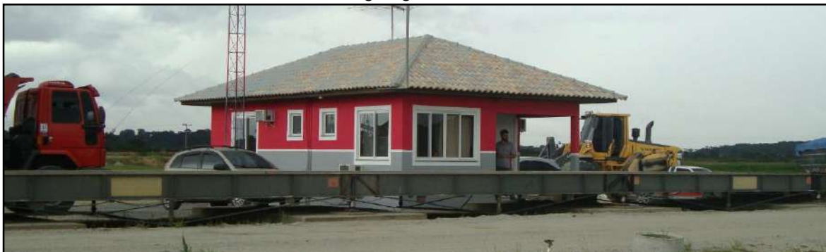
FOTO 22 – Balança rodoviária eletrônica para controle de saída do produto comercializado em tonelada.
