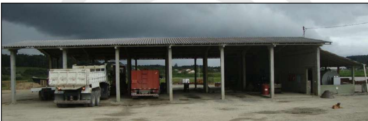
FOTO 23 – Barracão que abriga a garagem, oficina, almoxarifado, tanque de óleo diesel coberto com cortina de proteção em concreto e bico de abastecimento.
