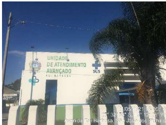
Figura 19 - Unidade de Atendimento Avançado, a aproximadamente 450m do empreendimento.
