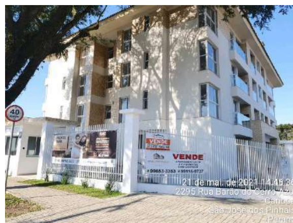
Figura 16 - Fachada do Empreendimento, Bloco 01 em fase final de obra.
