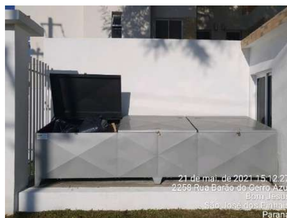
Figura 12 - Lixeiras externas do empreendimento.
