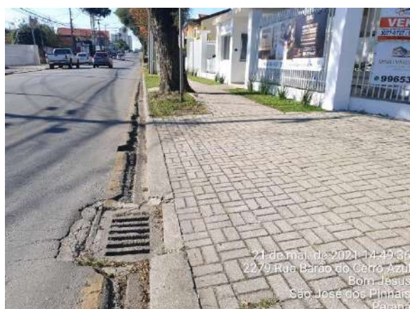
Figura 11 - Boca de lobo na Rua Barão do Cerro Azul, em frente ao empreendimento.
