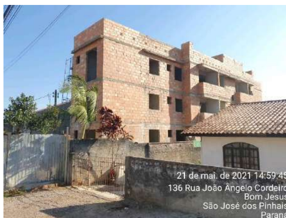
Figura 23 - Empreendimento imobiliário sendo construído a aproximadamente 250 metros do Euro Residence.
