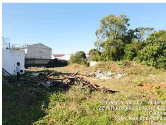
Figura 6 - Vegetação rasteira e entulhos da construção do Bloco 01 no interior do lote.
