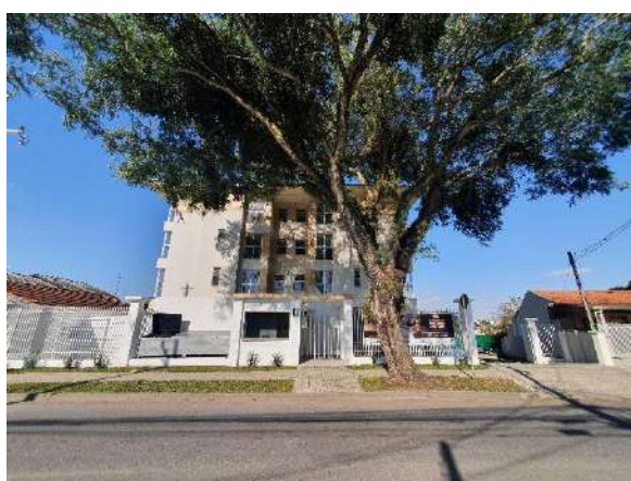
Figura 13 - Vista para entrada e saída de pedestres e veículos, na Rua Barão do Cerro Azul.
