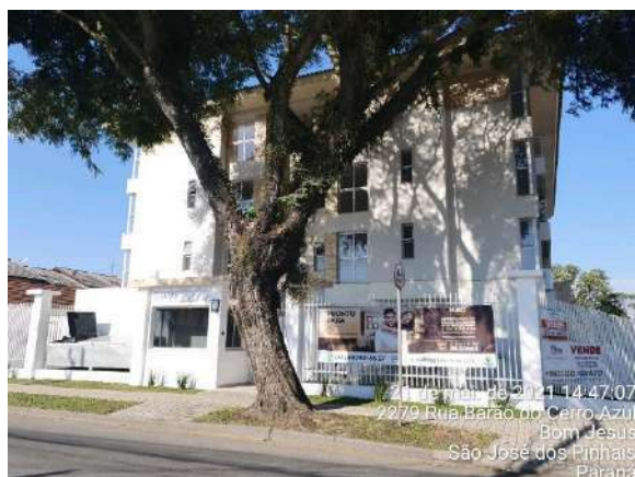
Figura 2 - Vista para a entrada do imóvel, Bloco 01 em fase final da obra.
