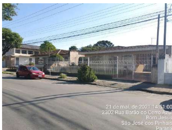
Figura 8 - Vista para as residências localizadas em frente ao empreendimento.
