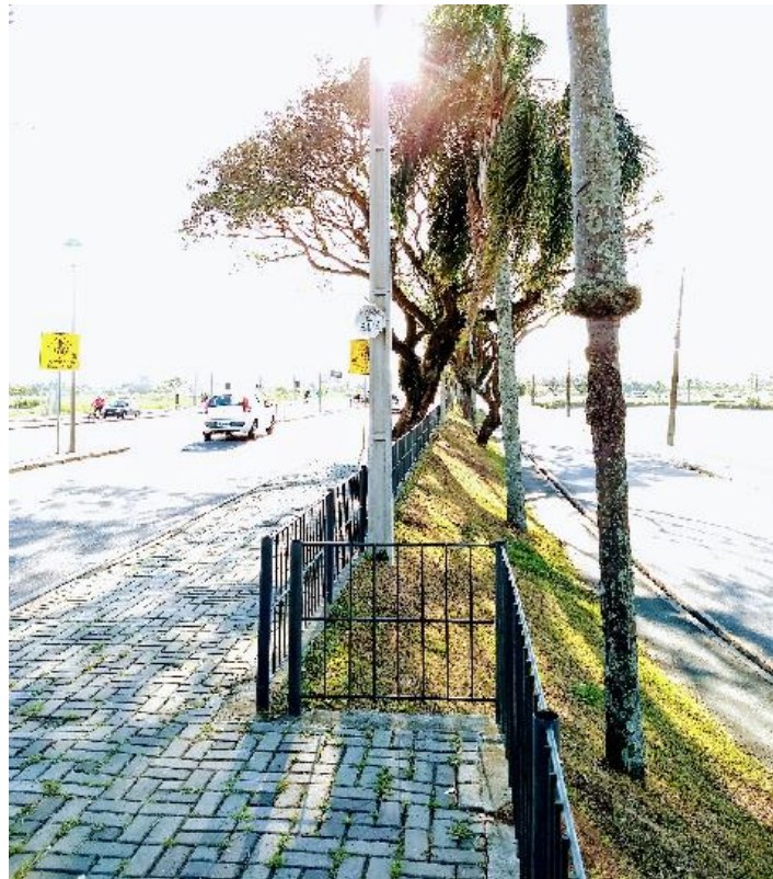
Figura 23 - Parada de ônibus no sentido São José dos Pinhais - Curitiba. Fonte: Monitore Engenharia
