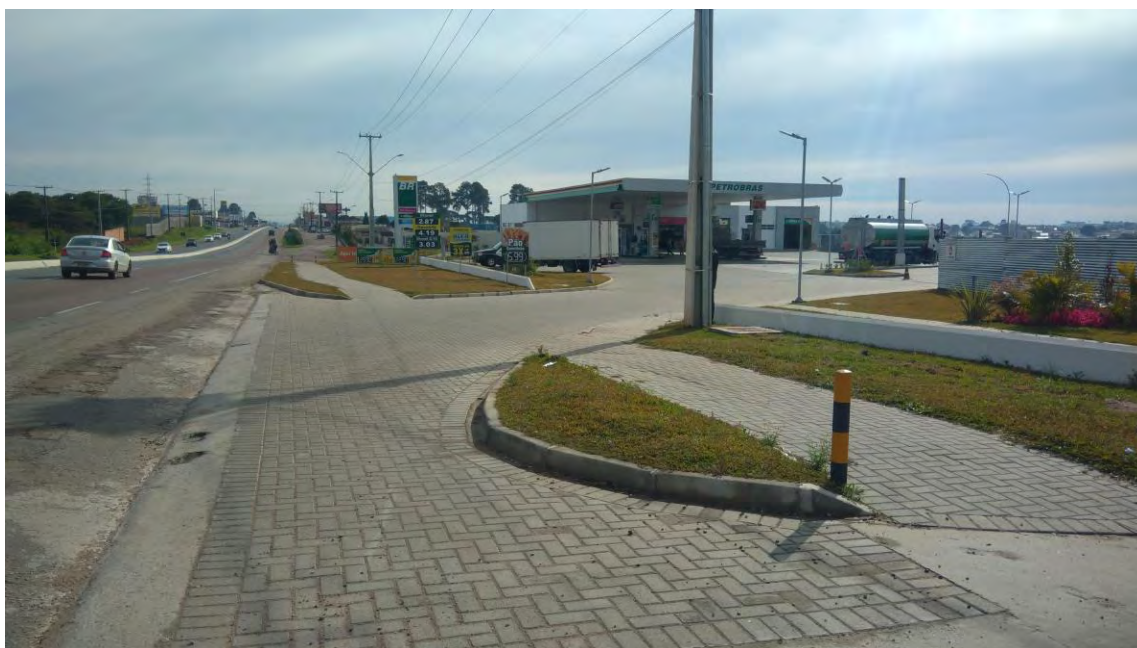
Foto 03 - Vista geral do Posto Campina (vista frontal direita)
