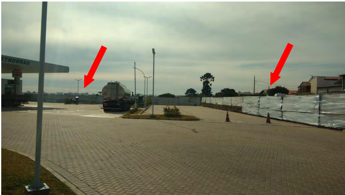
Foto 05 - Indicação da área a ser construída as lojas comerciais (lateral direita e fundos)
