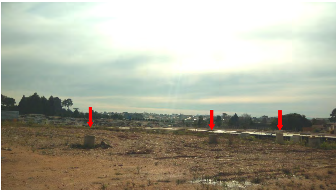
Foto 10 - Na área de implantação das lojas, tubulações de águas pluviais já instaladas
