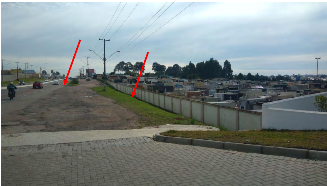
Foto 19 – Rodovia BR 376 (sentido Curitiba) Ausência de calçada e sinalização
