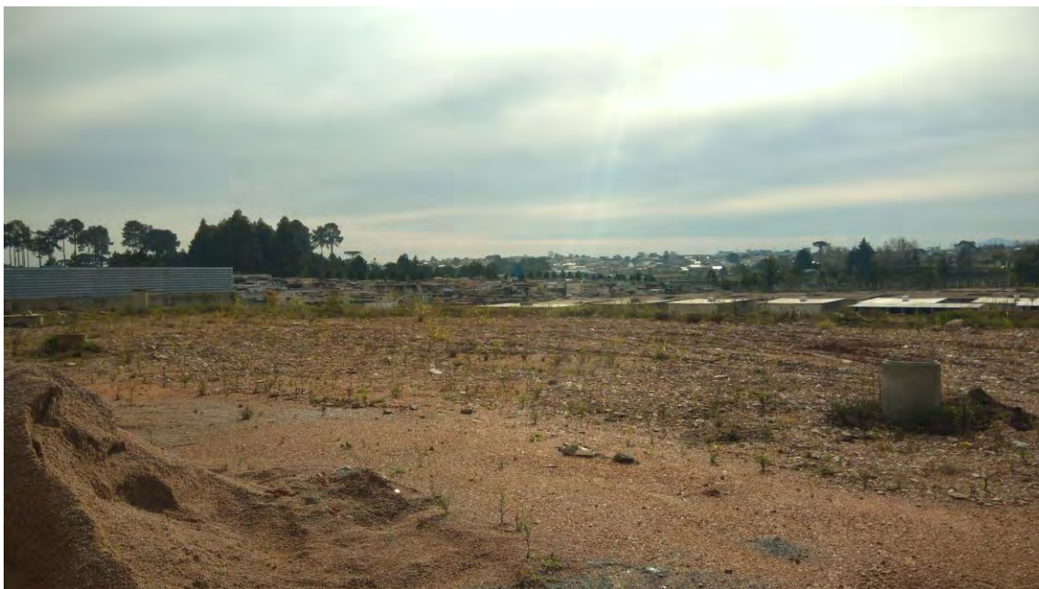
Foto 06 – Atual situação da área onde será implantada as lojas (fundos)
